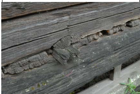
Vanha riihi, jonka lattialautoja voidaan kiristää kiilalla. Syntyvän raon päälle laitetaan pyöreäpintainen lauta.
